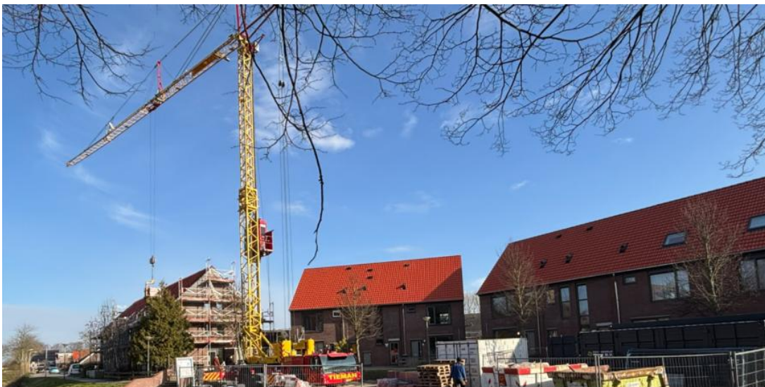
Hendsweel: Bij het laatste blok wordt het dak geïsoleerd
